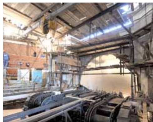
Заканчивается монтаж, такелаж эскалаторов в переходе, начинается третий, последний этап: отделочные работы
